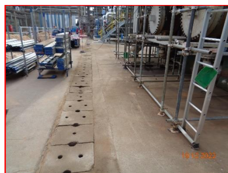
ภาพที่ 2.2-4 รางระบายน้ำฝนของโครงการ
